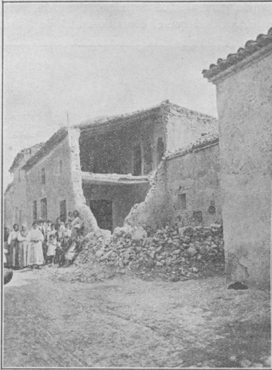
Fig. 2. a —Casa número 28 de la calle del Reloj, en Lorquí, destruida por los terremotos.
