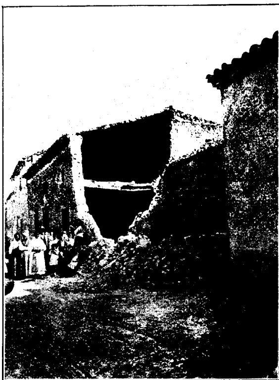
Fig. 2.ª—Casa número 28 de la calle del Reloj, en Lorquí, destruída por los terremotos.
