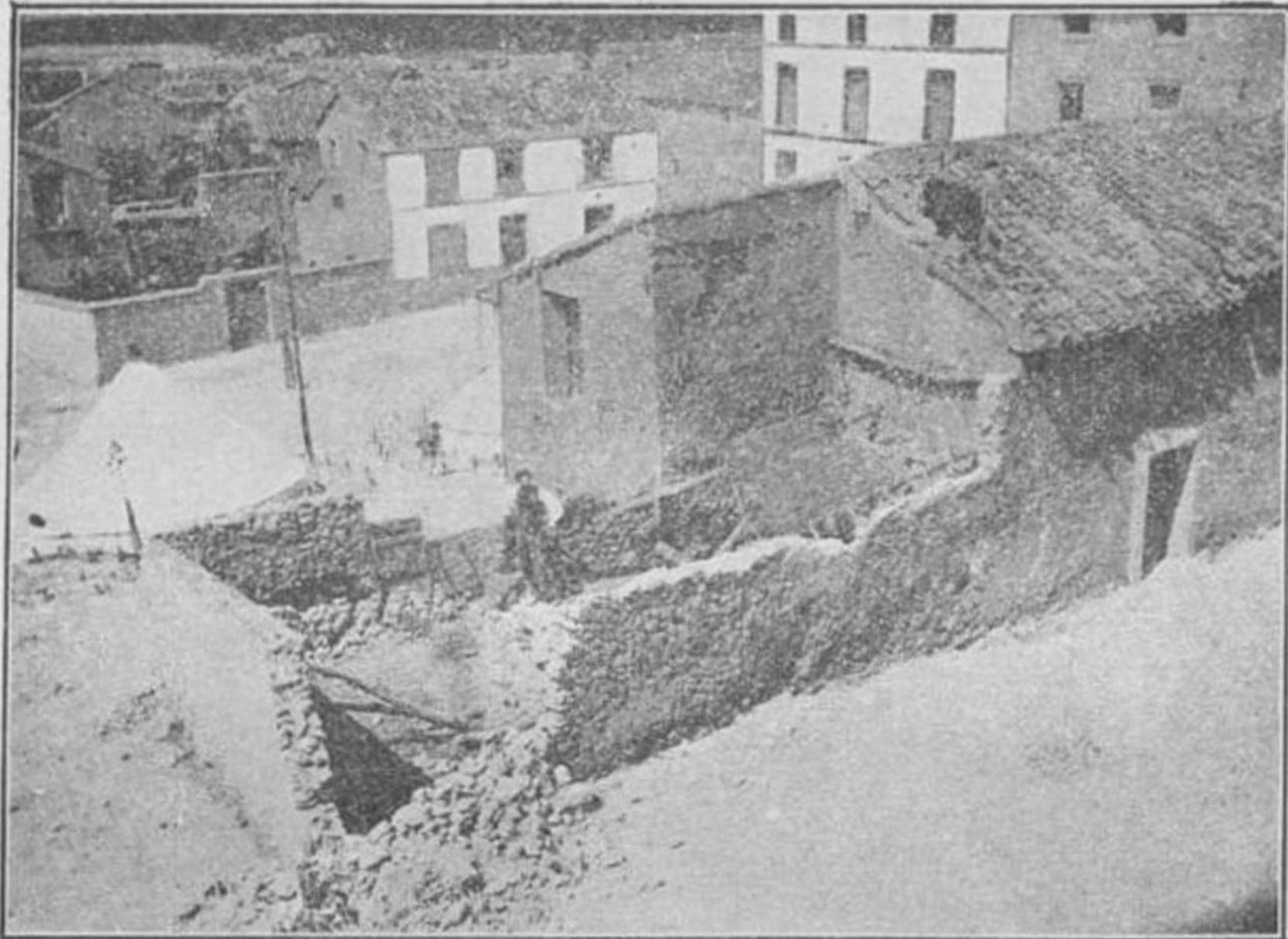
Fig. 1.ª—La plaza de Lorquí con casas destruidas.
